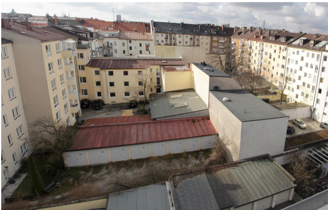
Abbildung 9: Perspektive auf den Hinterhof der Blockbebauung (Foto: ZSK TP1)
