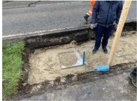
Einbau der Edelstahlwannen, Unterbau verfüllt mit Sand 0/3 (26.04.22)
