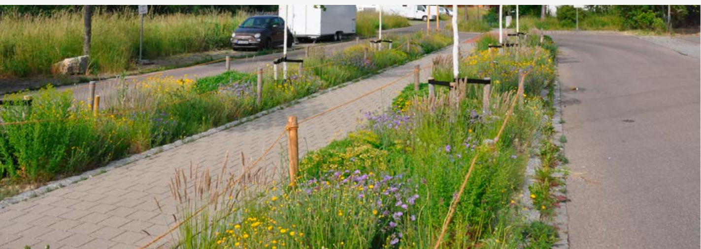
Abbildung 42: Beispielhafte Darstellung einer Versickerungsmulde im Straßenraum
