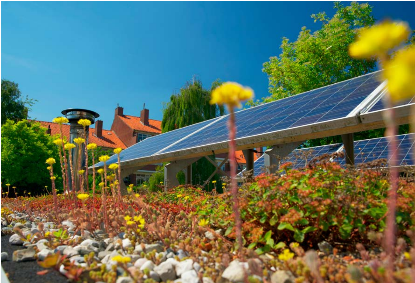
Abbildung 17: Dachbegrünung mit PV-Anlagen
