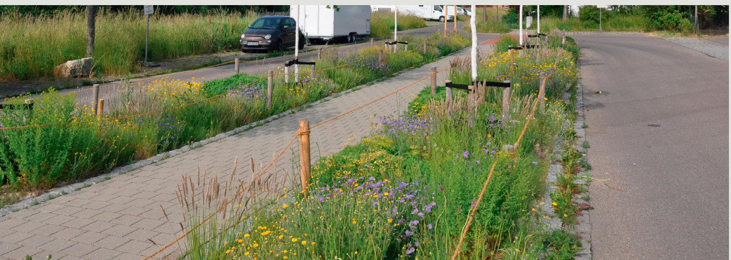
Abbildung 42: Beispielhafte Darstellung einer Versickerungsmulde im Straßenraum
