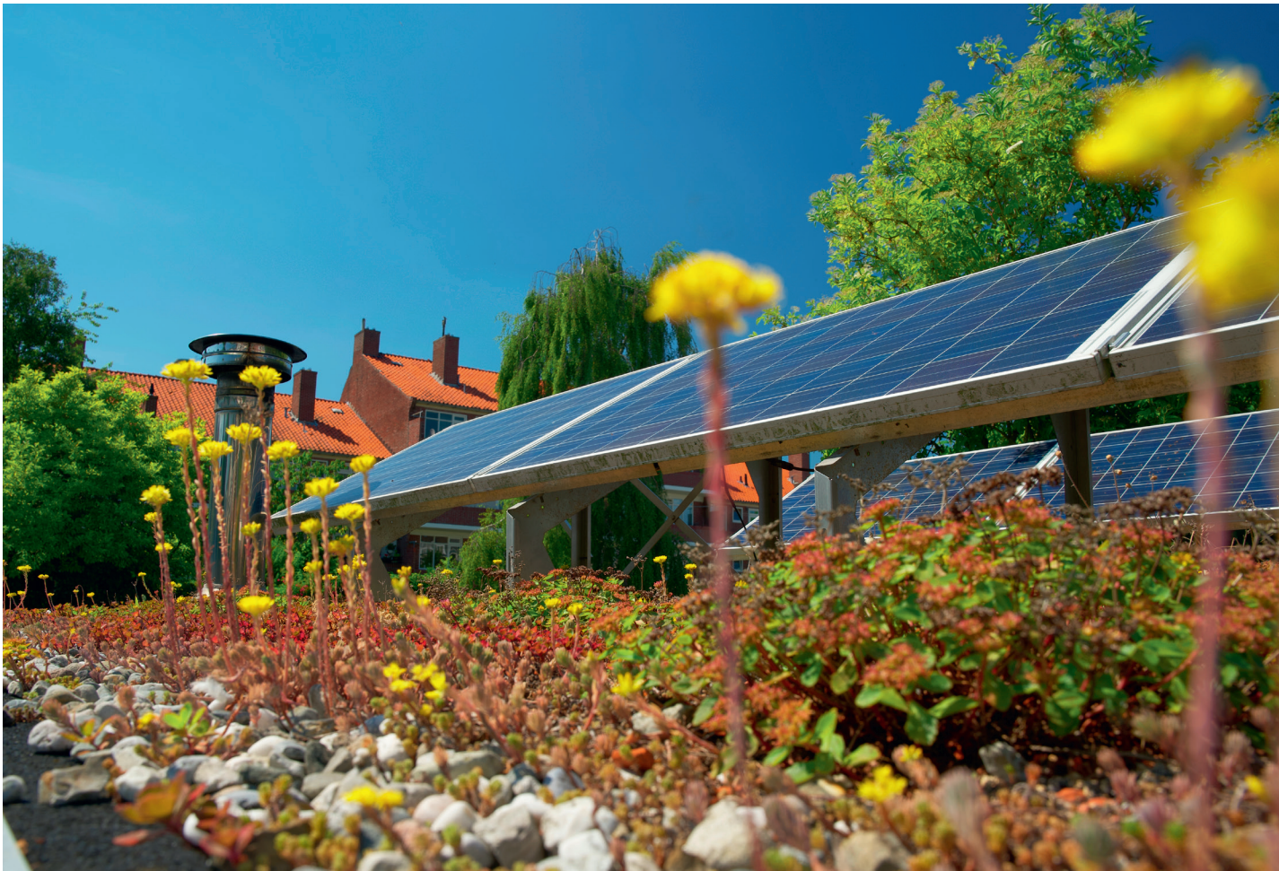
Abbildung 17: Dachbegrünung mit PV-Anlagen
