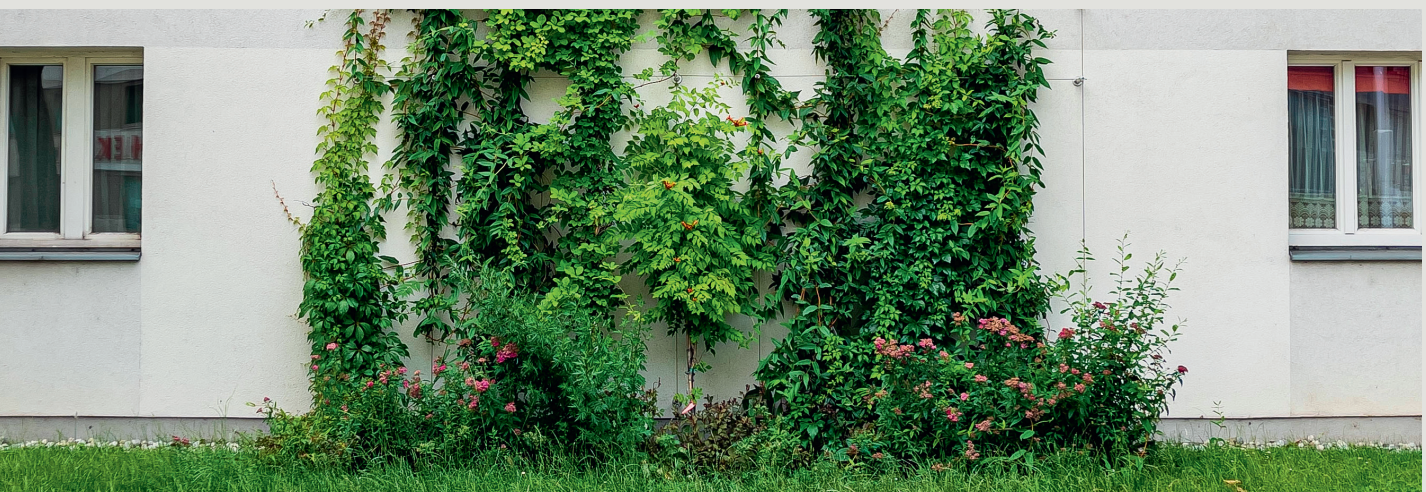
Abbildung 52: Beispielhafte Darstellung einer bodengebundenen Fassadenbegrünung
