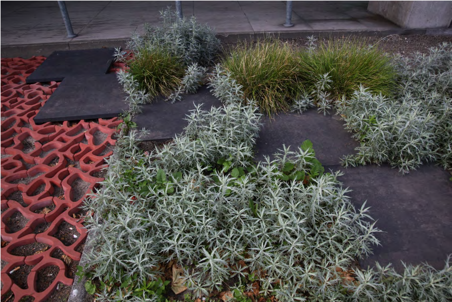
Wasserdurchlässige Beläge Rotterdam, Hofbogen
