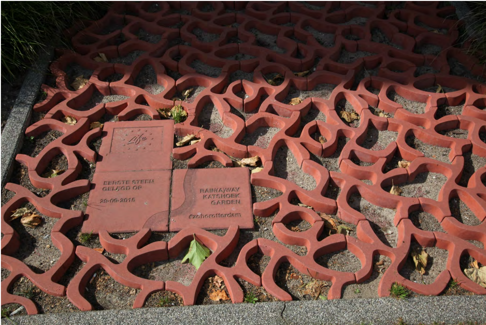
Wasserdurchlässige Beläge Rotterdam, Hofbogen
